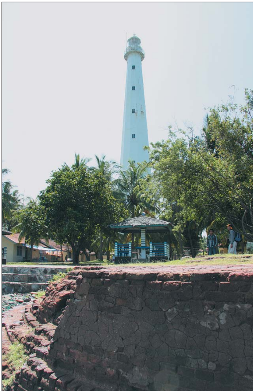
Рис.1. Массивное кирпичное основание башни маяка Аньер на берегу о-ва Ява, разрушенного цунами в 1883 г. (в 50 км от Кракатау). На заднем плане металлический маяк, построенный в 1885 г.
