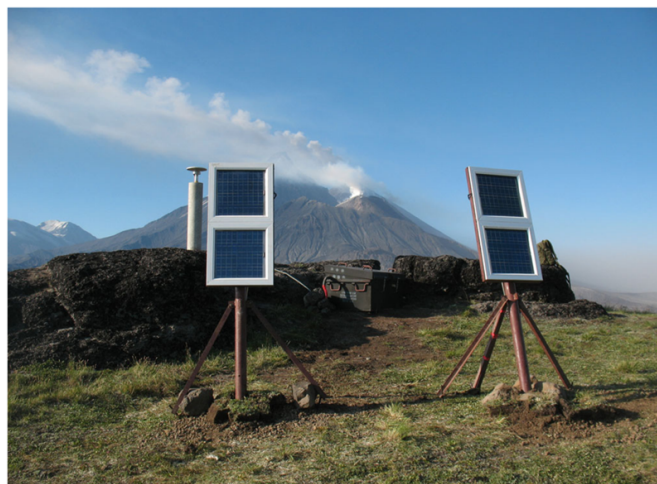
Рис. 3. GPS станция Vz06 оборудованная солнечными батареями, 2010 г.
