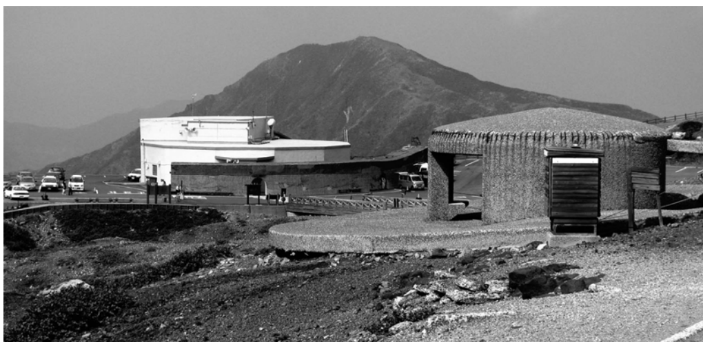
Рис. 2. Бетонированные укрытия от вулканических бомб на смотровой площадке кратера Накадаке вулкана Асо (о-в Кюсю, Япония) (фото Е.Г.Петровой).
