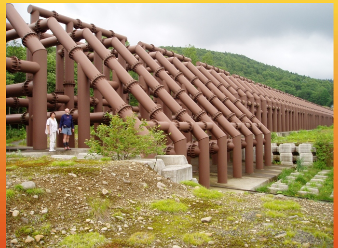
Рис. 3. Заградительное сооружение от схода наиболее крупных длыб обломочного вулканического материала. Фото М.Д. Герасименко.
